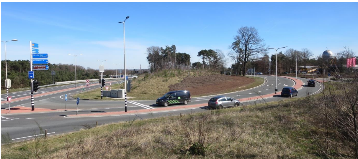
Fietssnelweg F35 Brug over N35 .
