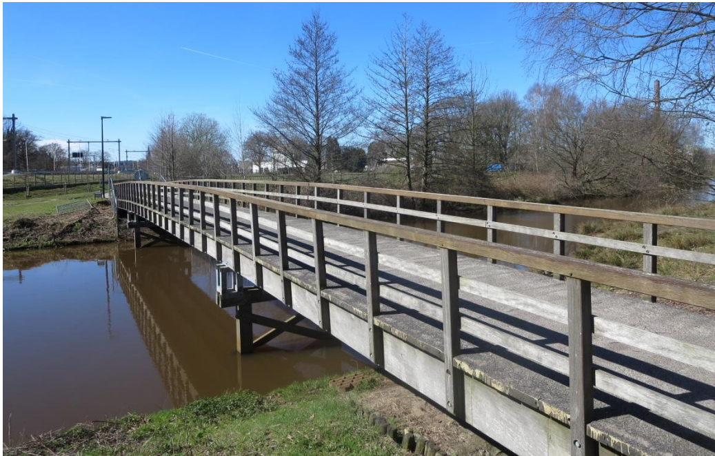
Fietssnelweg F35 Brug over de Regge.
