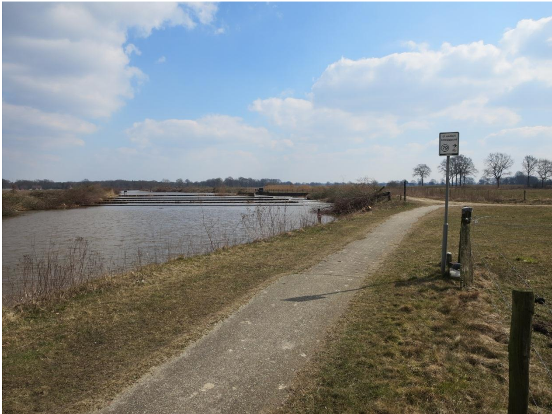
Stuw met vistrap in de Regge.
