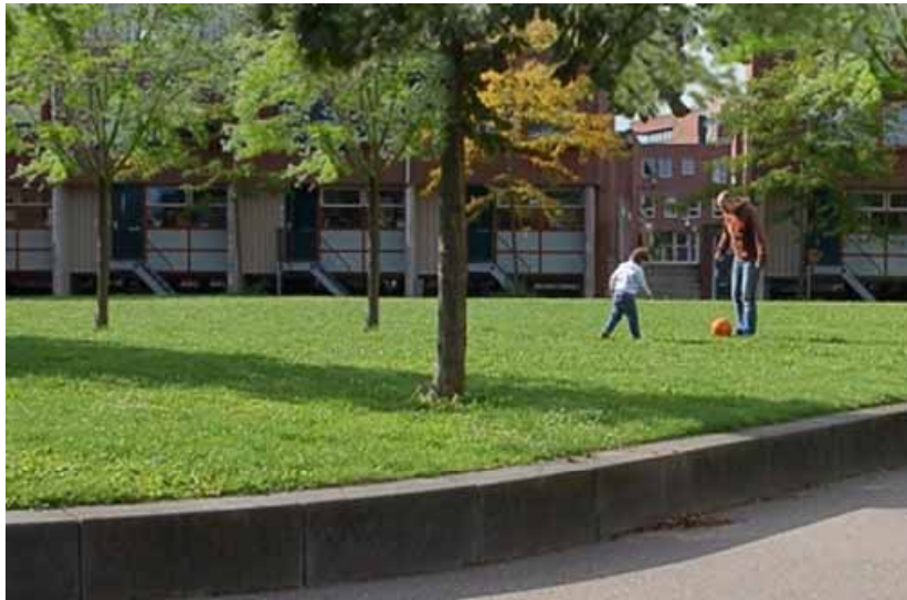
BETONNEN RAND LANGS VAK ALS BANK
