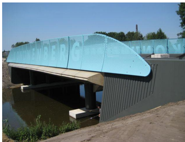
Spoorbrug Konijnenberg over de Regge
