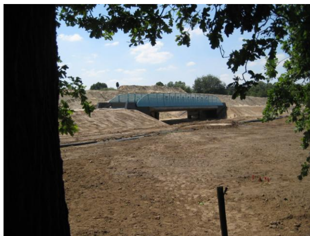
Spoorbrug Eversberg over de nevengeul
