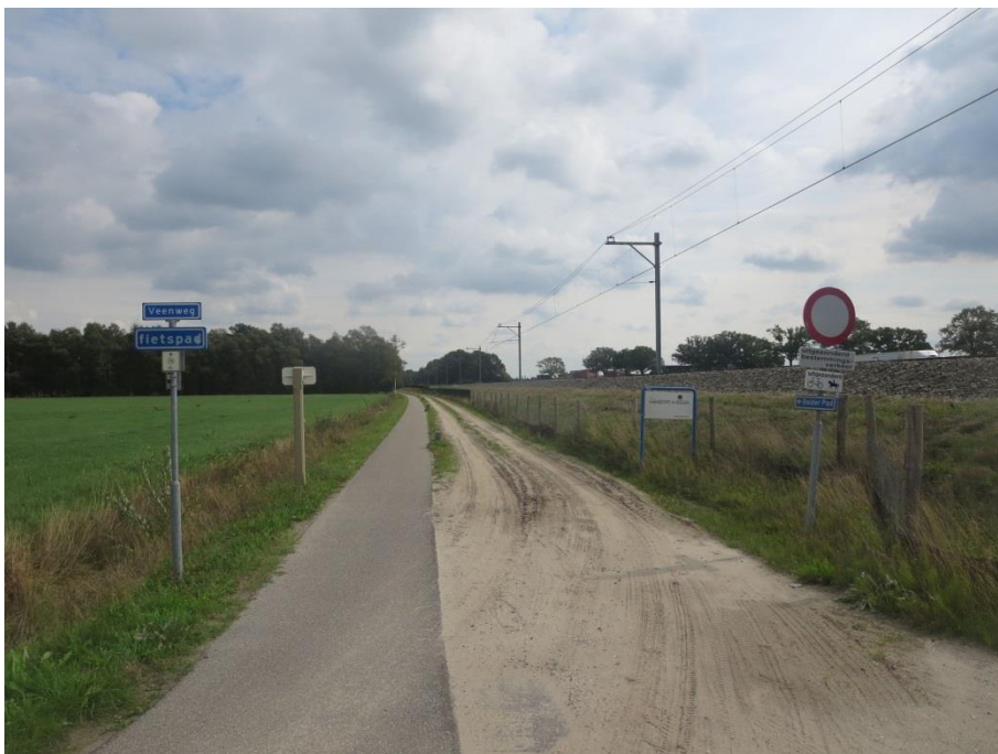
Fietssnelweg F35 Bolderpad.
