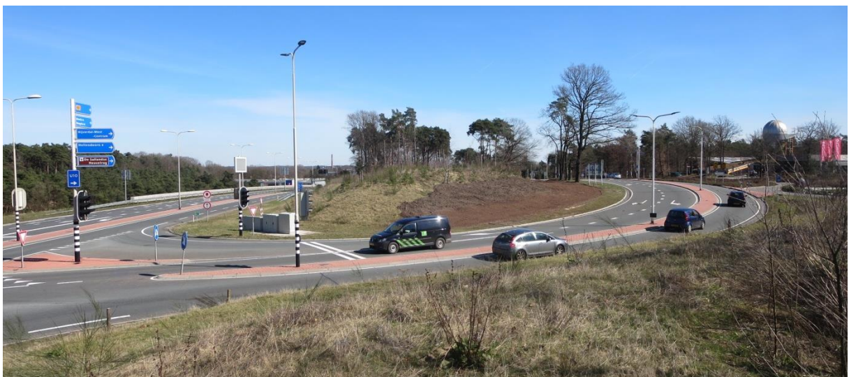
Fietssnelweg F35 Brug over N35 .
