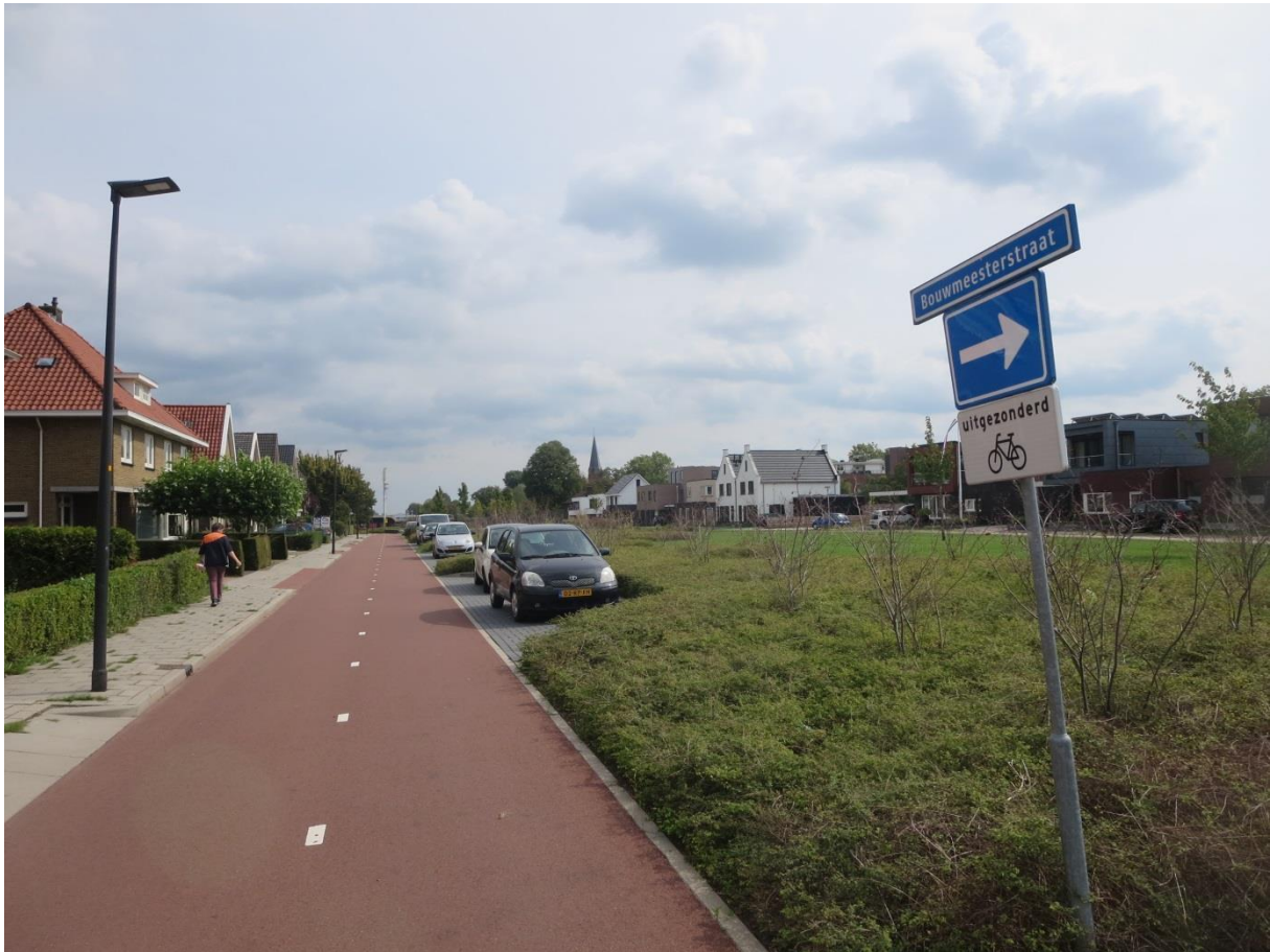
Fietssnelweg F35 Bouwmeesterstraat.
