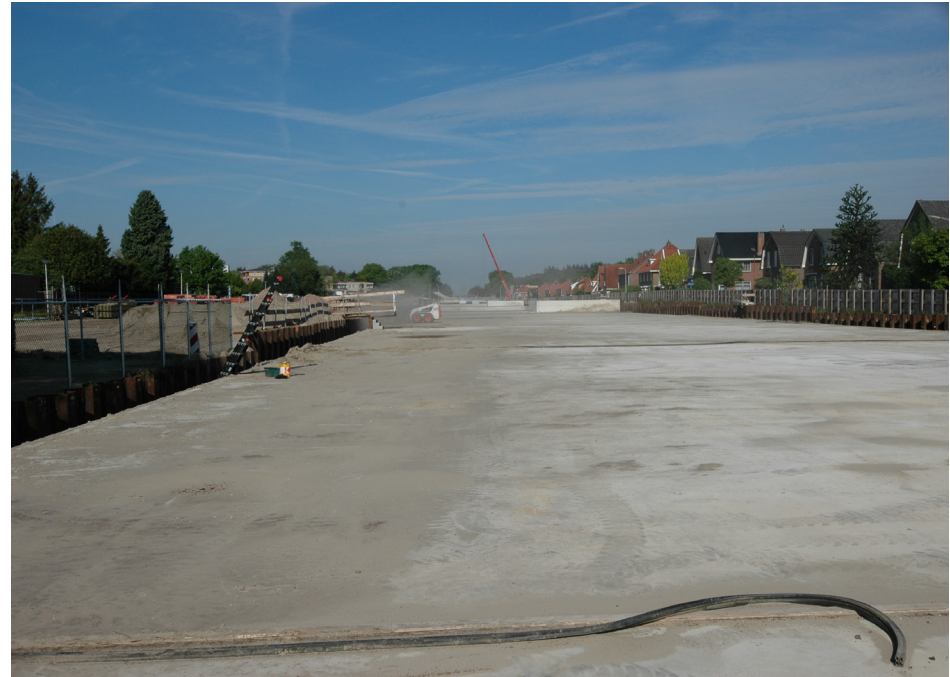
Het tunneldak voor de oplevering van de Bouwmeesterstraat (rechts)
