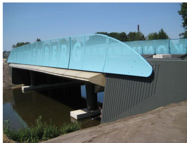
Spoorbrug Konijnenberg over de Regge
